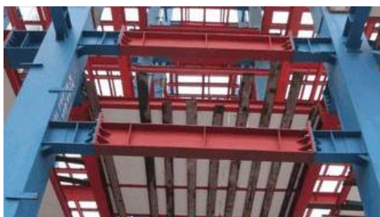
شکل ۳- اتصال ستون درختی برای اتصال تیر به ستون
